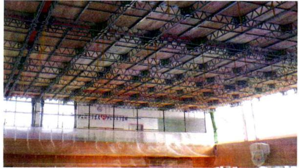
所作業での墜落・転落の危険がなくなりました。作業床がフラットなため、暗所での作業も安全に施工することができます。吊り足場上での作業は広い空間で行うことができ、作業効率が飛躍的に向上しています。
