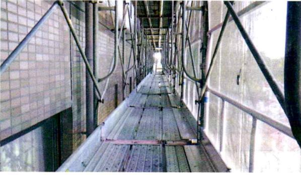
当社では新築・改修（高層 / 中層 / 低層）足場、橋梁などの足場工事において、施工規模の大きさに関わらず、様々な場面で先行手摺を使用した安全で作業性の良い足場を提供しています。
